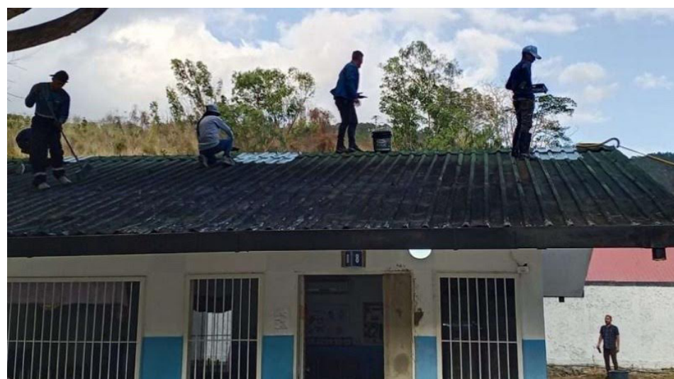
Las reparaciones se efectúan a velocidad redoblada
