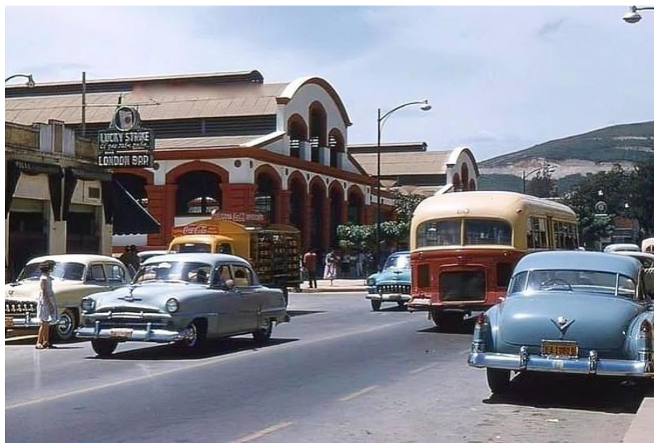
Su fachada ha sido casi la misma desde su inauguración
